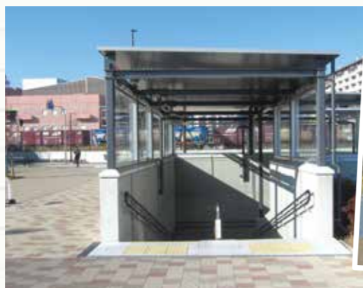
アンダーパスの立命館大学側。東階段室。
